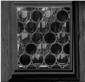
*Окна со свинцовыми перемычками были характерны для средневекового Нюрнберга. В Старом городе они и сейчас встречаются довольно часто. Технология их изготовления известна ещё с X в. Свинцовые стерженьки отливали в железных или деревянных формах, затем расплющивали в полоски. Этими полосками обертывали края заранее нарезанных кружков листового стекла, раскладывали их на большом столе, плотно пригоняли один к другому и спаивали.*
